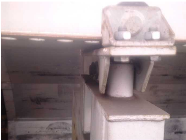
Рис. 4. Вузол кріплення перегородки до направляючої балки
