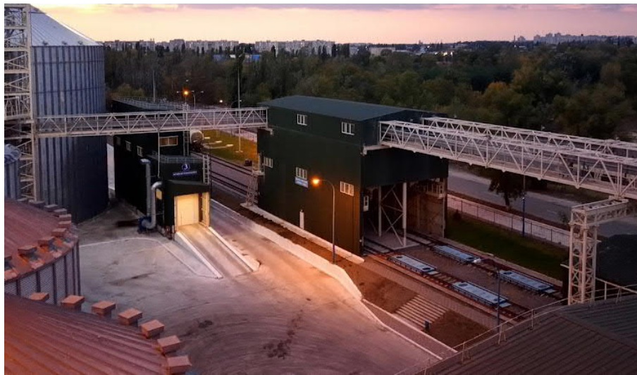
Рис. 6. Дільниця залізничного транспорту на терміналі
